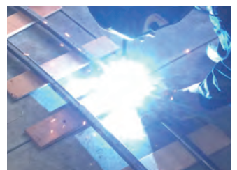
溶接 電気機関車のレール製作
